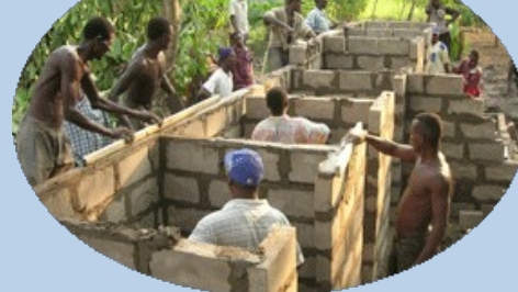
Mercredi 20 décembre Les latrines en construction
